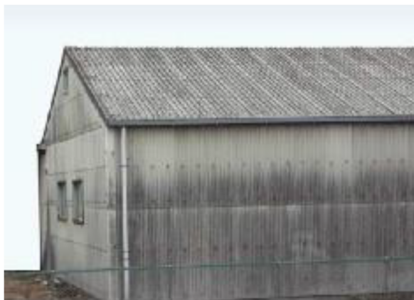
石綿含有スレート波板（屋根・外壁）
