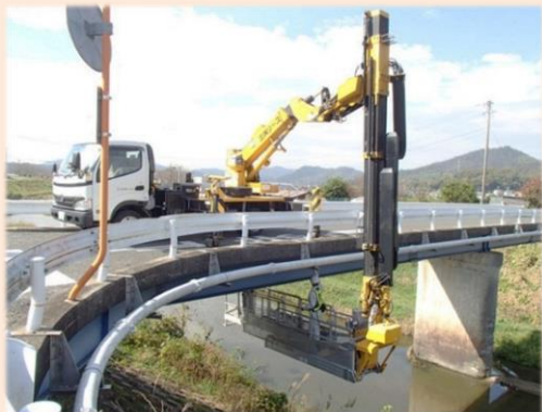
橋梁点検車による点検
