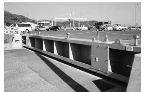
防潮堤開閉ゲート整備事業
