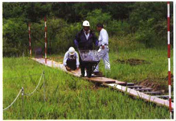
木道施設工事 (C地区)
