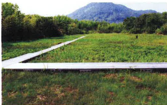
木道完成 (C地区)
