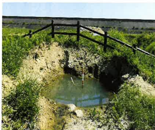
A地区・海水流入施設検査現場
