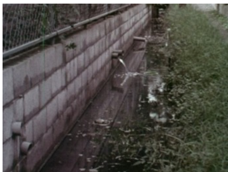
（下水道整備前）
