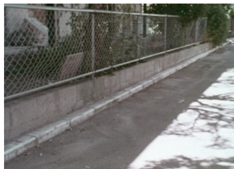
（下水道整備後）
