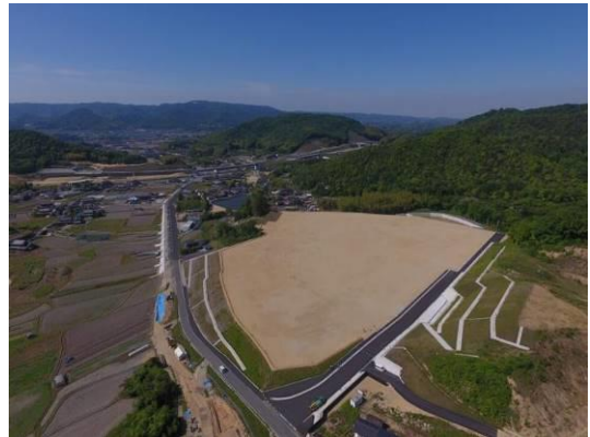
浅口工業団地先行造成区域 A 地区
