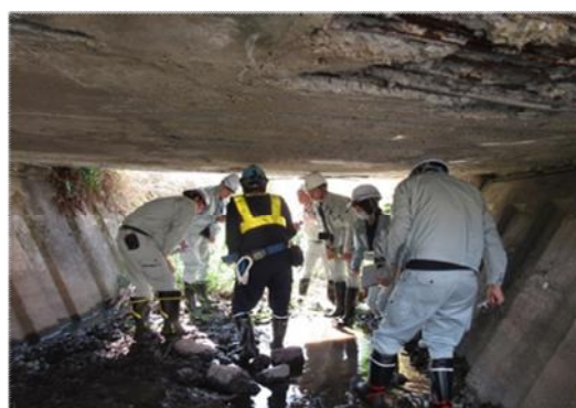
橋梁点検実習状況
