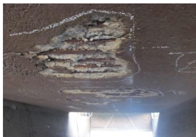
断面修復（八重沖 2 号橋）
