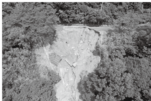
板峠目鑑線（金光町上竹）の復旧
