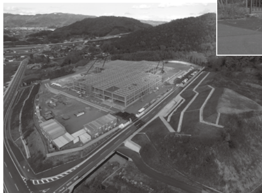
工場の建設が進む 浅口工業団地A地区
