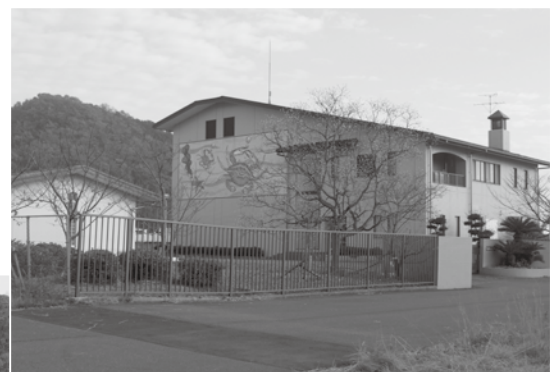
改築が完了した奇島浄化センター
