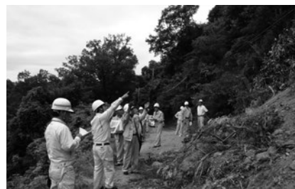
上竹地区の市道板峠目鑑線の現場を視察
