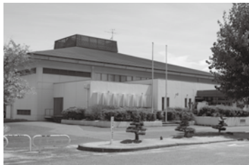
天草公園体育館
