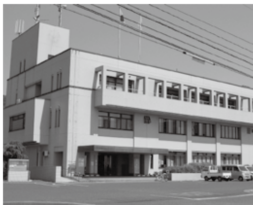
寄島総合支所
