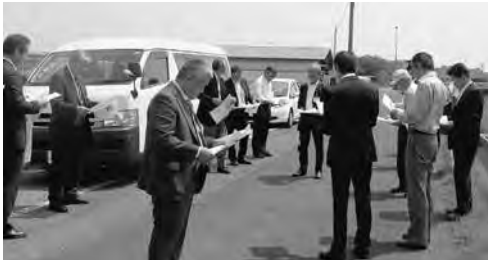
金光駅南口工事現場
