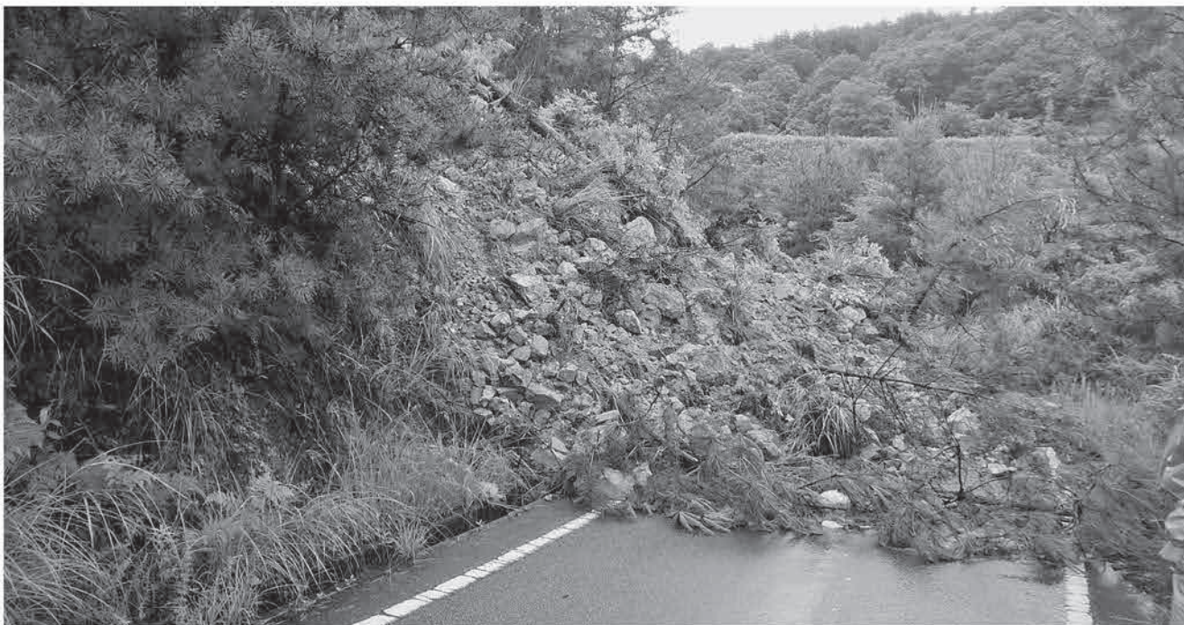
大雨で崩落した土砂
