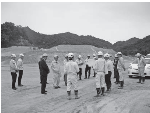
工業団地造成工事現場を視察
