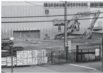
鴨方駅南洪水調整池復旧工事
