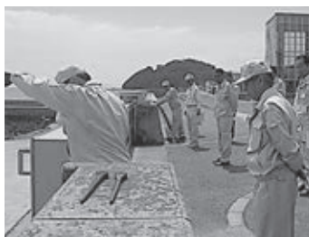
防潮堤開閉ゲート
