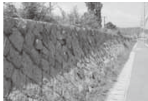
寄島中学校南の石積塀
