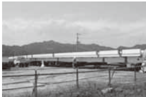
製作済みの橋げた
