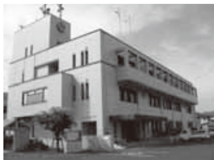
寄島総合支所
