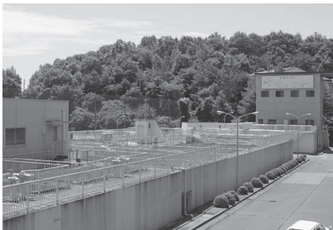
岡山県西南水道企業団(鴨方浄水場)
