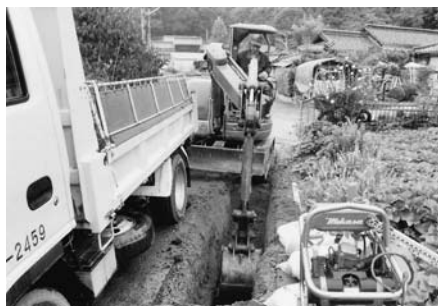
下水道整備工事中の現場
