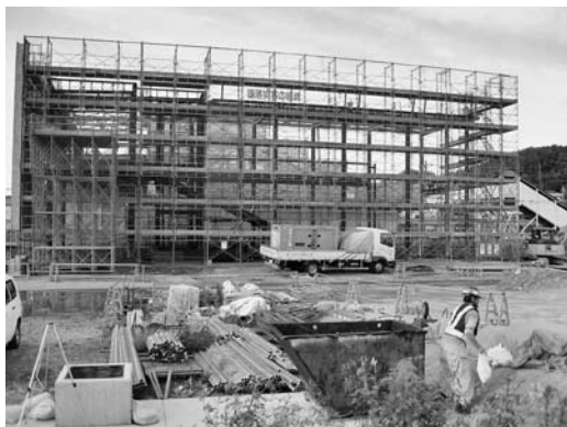
進む鴨方駅橋上化工事
