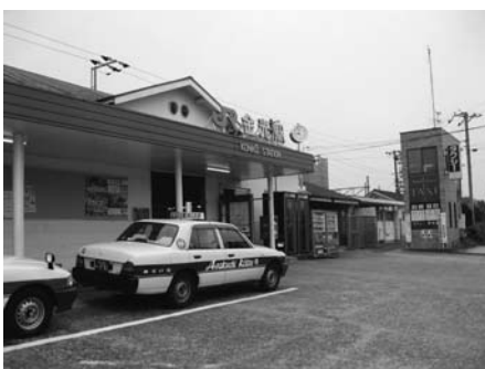
整備が望まれる金光駅前
