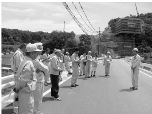
国道2号バイパス工事現場（金光町大谷）を視察（5月28日）
