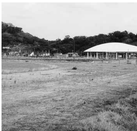
フットサル建設予定地(寄島干拓地内)
