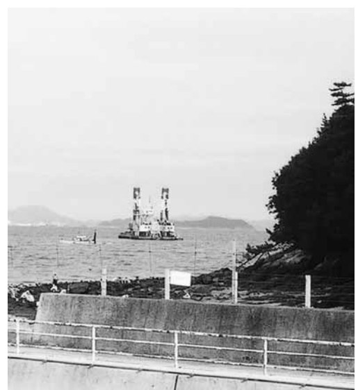
寄島漁港の航路浚渫
