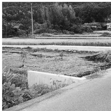
コンクリート擁壁
