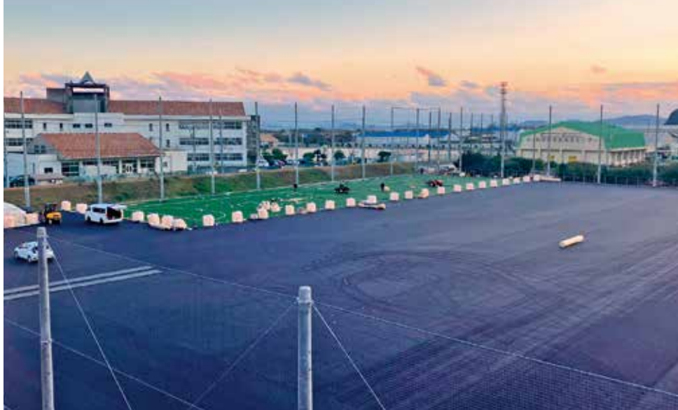
人工芝グラウンド施設整備の様子
